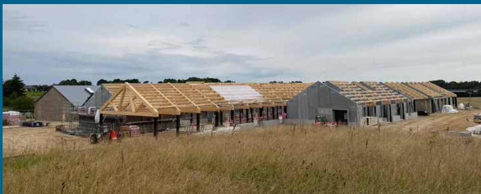
Gubsø Garage: Værksteder, udstillingsarealer, garageanlæg, restaurant og kontorer til udstilling af veteranbiler, fortrinsvis Bugatti. Under opførelse. Arkitekt, Cornelius Vöge.
